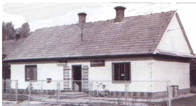
Budynek Szkoły podstawowej do 1952 r.
